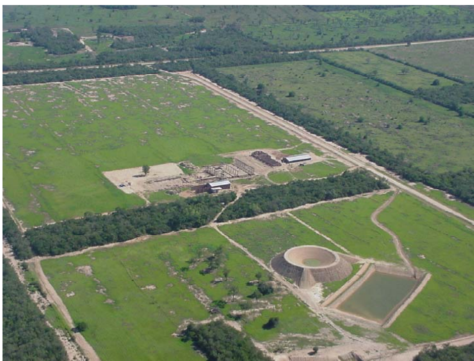
Sistema de aprovechamiento del Acuífero de Neudorf por el método de recarga artificial- Vista de Canaletas colectoras, tajamares y tanque australiano. (Foto: Bruno Brack)
