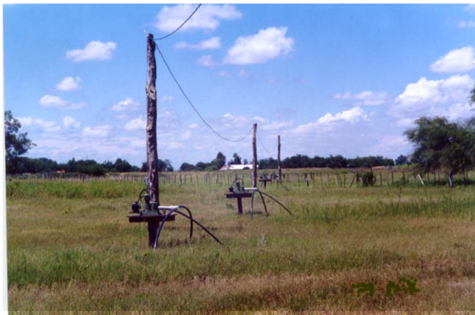
Sistema de pozos de agua ( Neudorf), seis en total, perforados en línea en un ambiente de paleocauce. El agua dulce corresponde a la lente de agua dulce sobre agua salada. (Foto H.Wiens)
